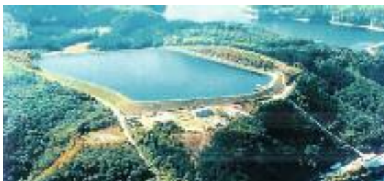
Das Pumpspeicherwerk Wendefurth bietet schon heute ein erhebliches Speicherpotential.
